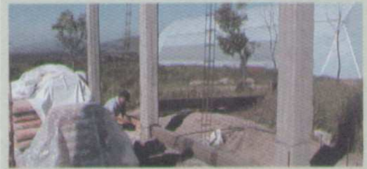
CONSTRUCCIÓN DE LA SALA DE FERTIRRIEGO EN LA FINCA PILOTO.
